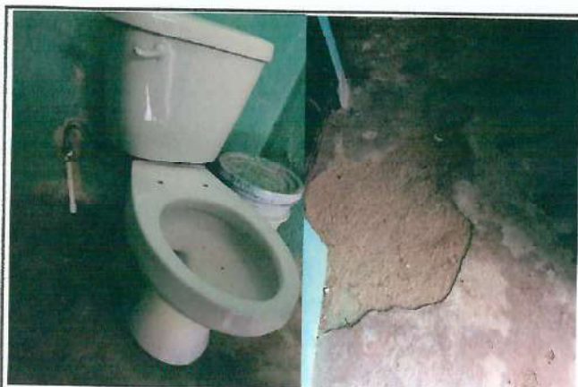
Foto 3: Mejoramiento a Servicios sanitarios
