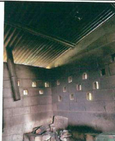
Foto 2: Mejoramiento y reparación de Cocina
