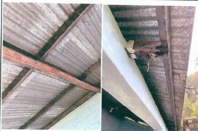
Foto 1: Mejoramiento a techo de aula
